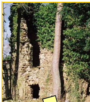
Réparation de la tour
